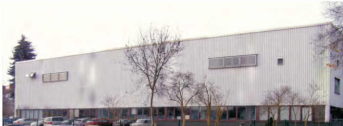
Die Laborhalle vor der Sanierung
