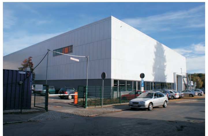
Sanierter Laborhalle im Oktober 2012
