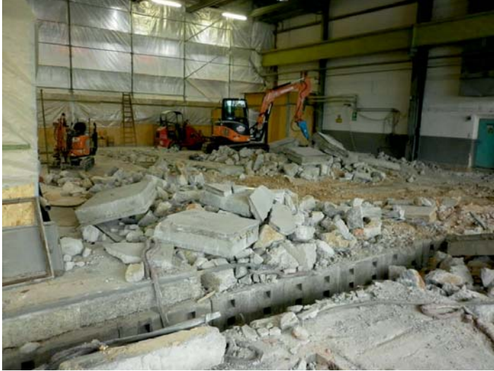
Baubeginn Februar 2013 – nach vergeblichem Einsatz mit manueller Abbruchtechnik kamen die Bagger
