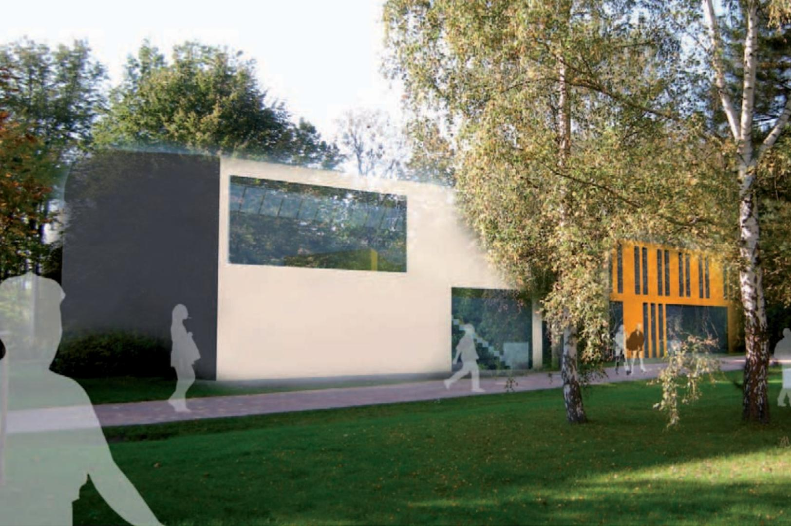
Der Entwurf von Cornelia Ottiger bildet zwei Baukörper mit gegenläufigen Pultdächern aus, die durch einen Mittelbau miteinander verbunden werden.
